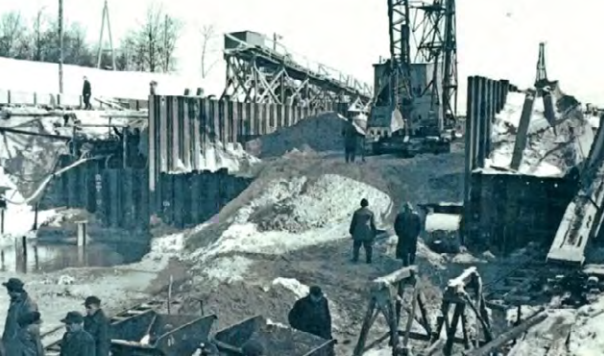
Bau der Schleuse bei Schönwalde-Glien©Kurt Propper
